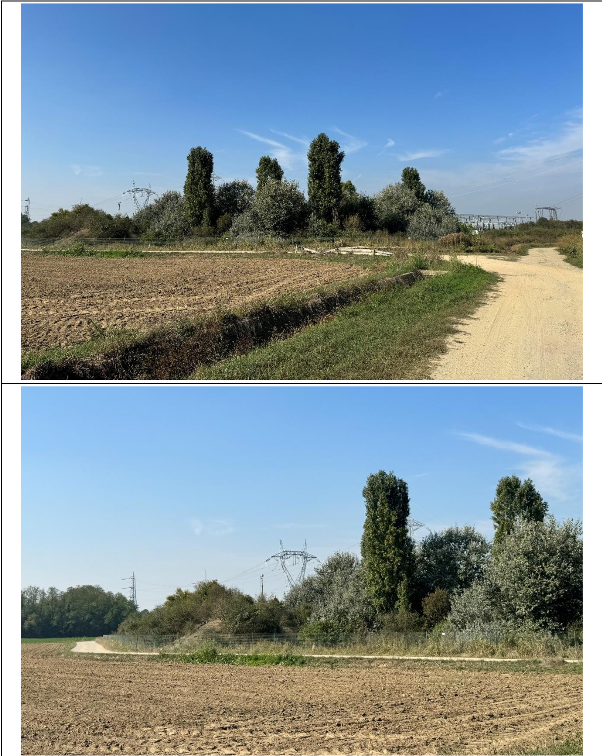
Figura 2 Stazione elettrica Maleo
