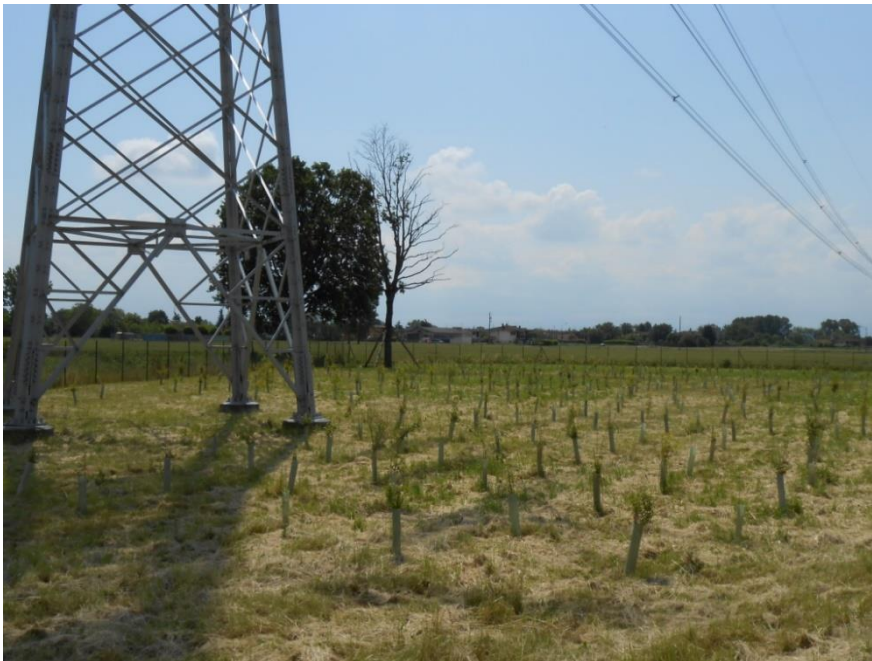
Figura 6 Intervento di messa a dimora di alberi e arbusti sulla linea 380 kV Chignolo Po – Maleo
