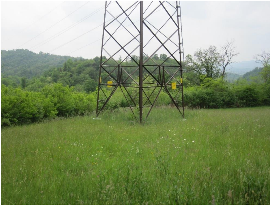
Figura 5 Intervento di inerbimento sulle linee 132 kV della Val D'Ossola Sud
