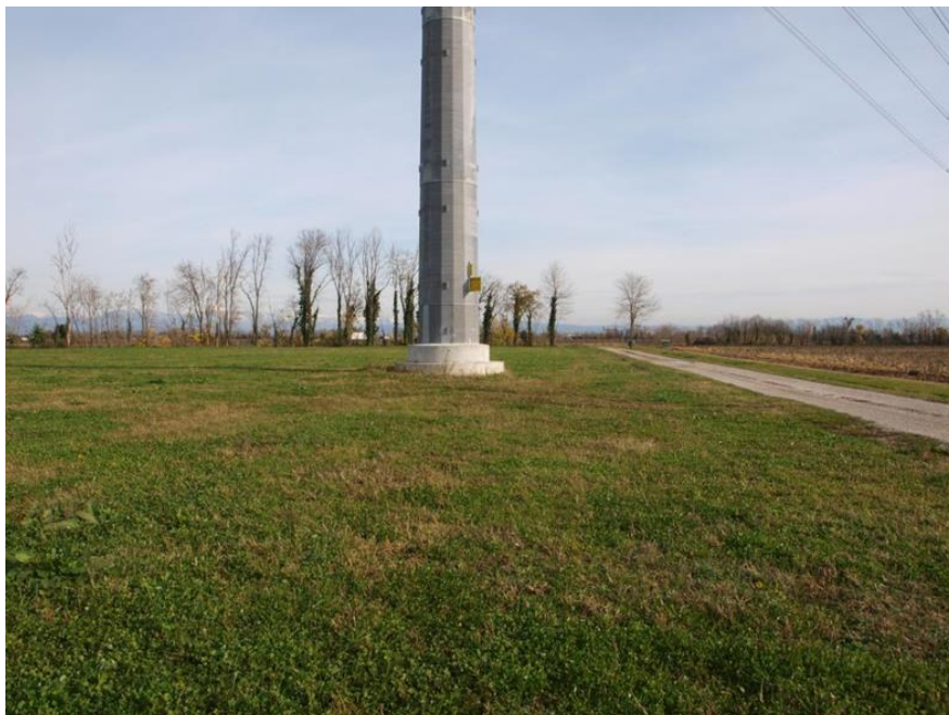
Figura 4 Intervento di ripristino ante-operam a prato sulla linea 380 kV Udine Ovest-Udine Sud
