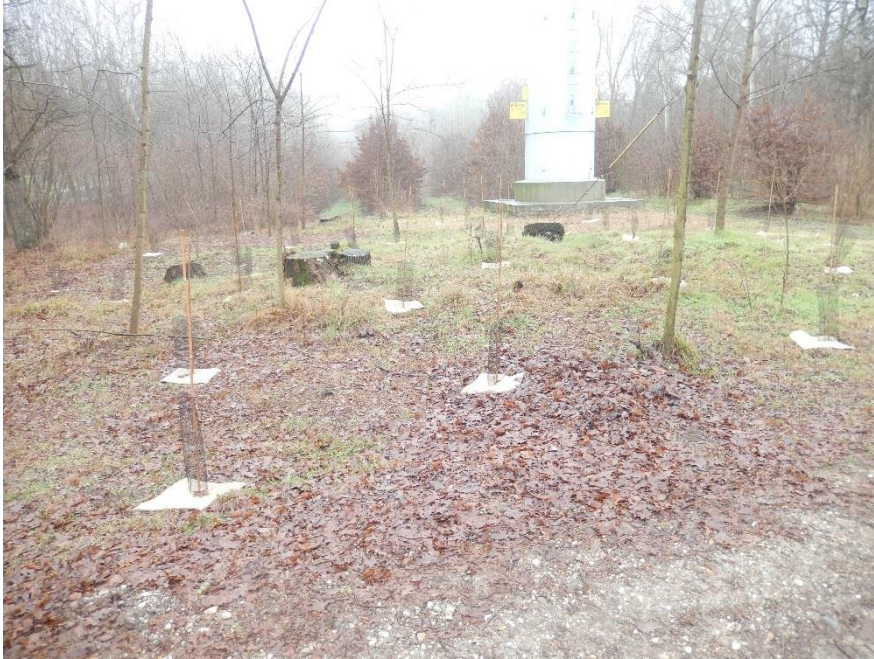
Figura 3 Interventi di ripristino nel Parco naturale della valle del Ticino sulla linea 380 kV Trino-Lacchiarella
